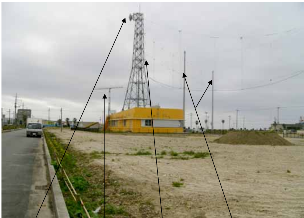
パラボラ・ログペリオアンテナ、地上 30mの鉄塔、コンクリート柱
