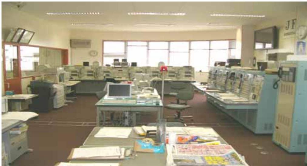
通信室：奥に漁業指導監督用27MHz帯通信卓、右奥に中短波、短波帯通信卓
