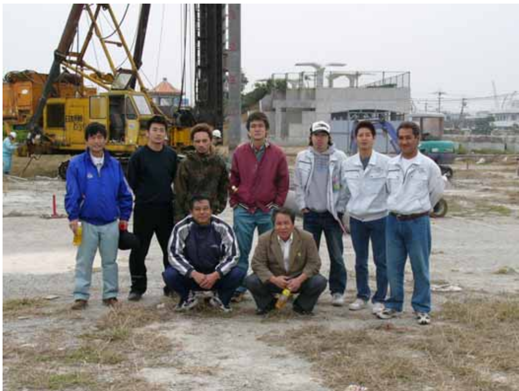
島袋局長中心に職員による杭打ち工事現場視察
